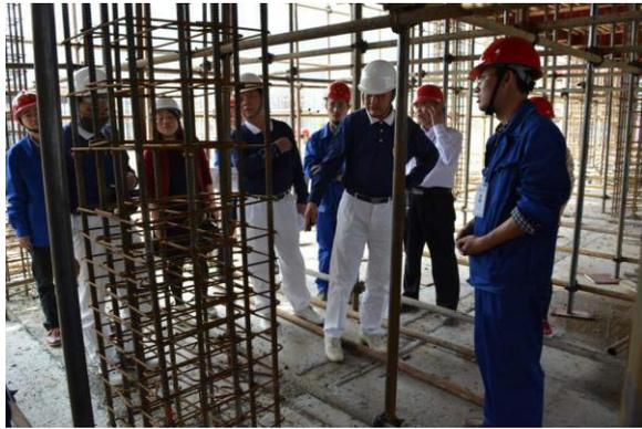
图 25 慈济建筑委员会检查教学楼柱钢筋绑扎及柱头清洁情况（2015 年 3 月 30 日）
