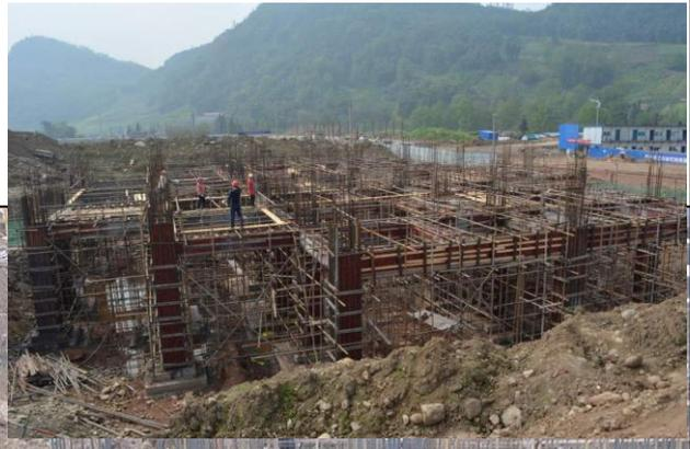
图 10 图书馆地梁及基础柱钢筋、模板完成现况
