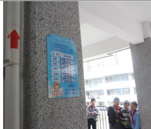
图 33 墙体外部统一使用水洗石头
