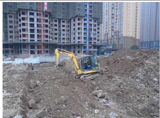
图 7 项目地基开工建设
