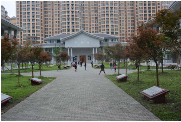
图 10 项目建筑工程完成
