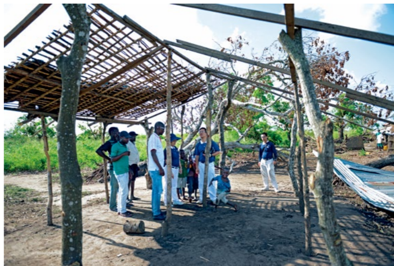
志工访视莫桑比克伊代风灾重灾区雅玛郡，筹划「建材包」内容。受灾居民急着重建家园，只要就近能找得到的材料就拿来盖房子。（摄影／蔡凯帆 2019.04.18）
