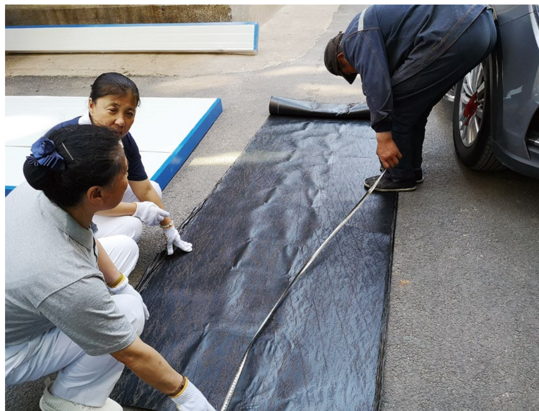
为了修缮甜甜家的阳台，志工帮防水师傅一起丈量防水涂层尺寸。摄影/刘乙颖
