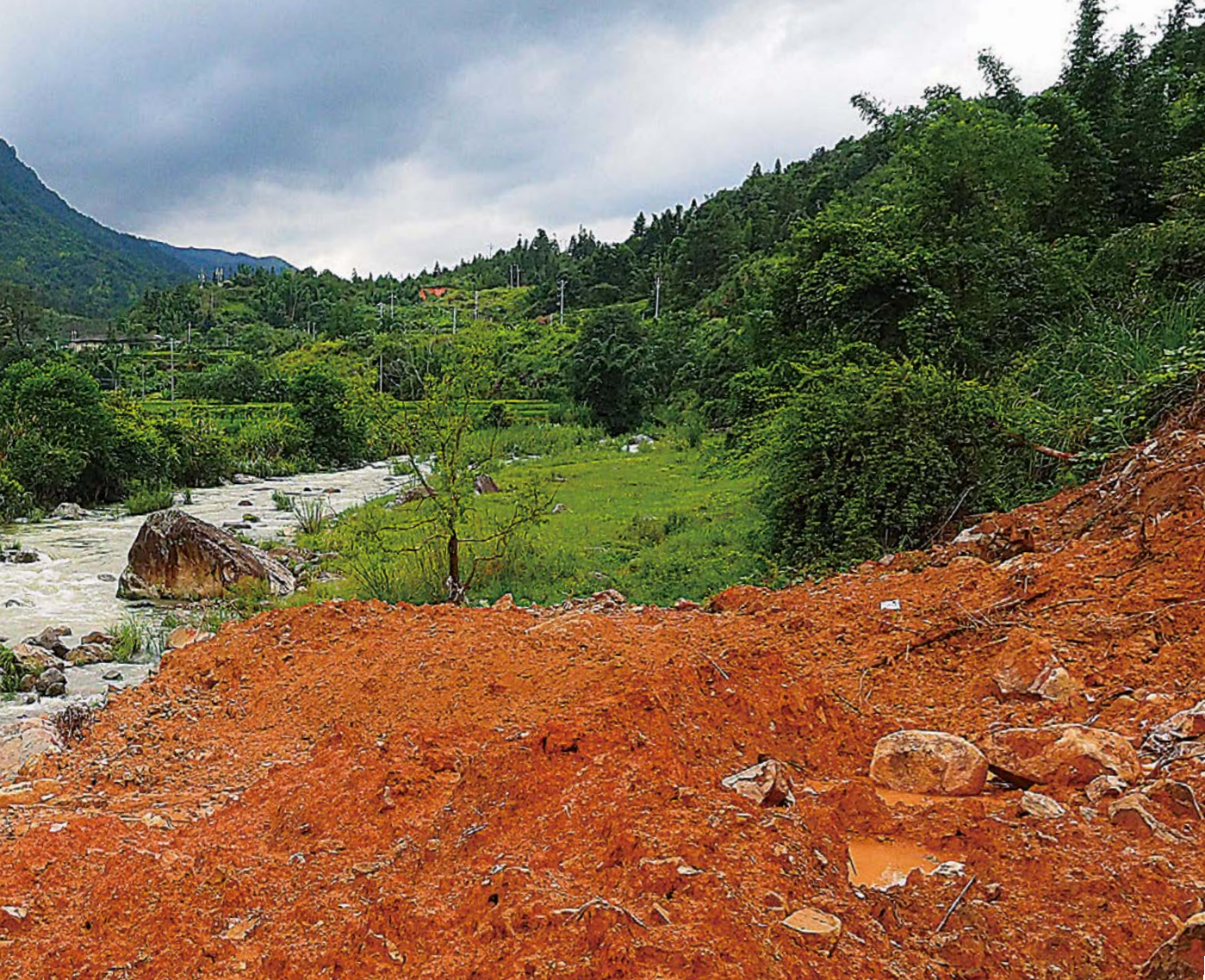
龙岩市永定区的国道三五七线湖坑镇新南村路段的山体滑坡，造成旅游大巴侧翻。（摄影/陈莉娜）
