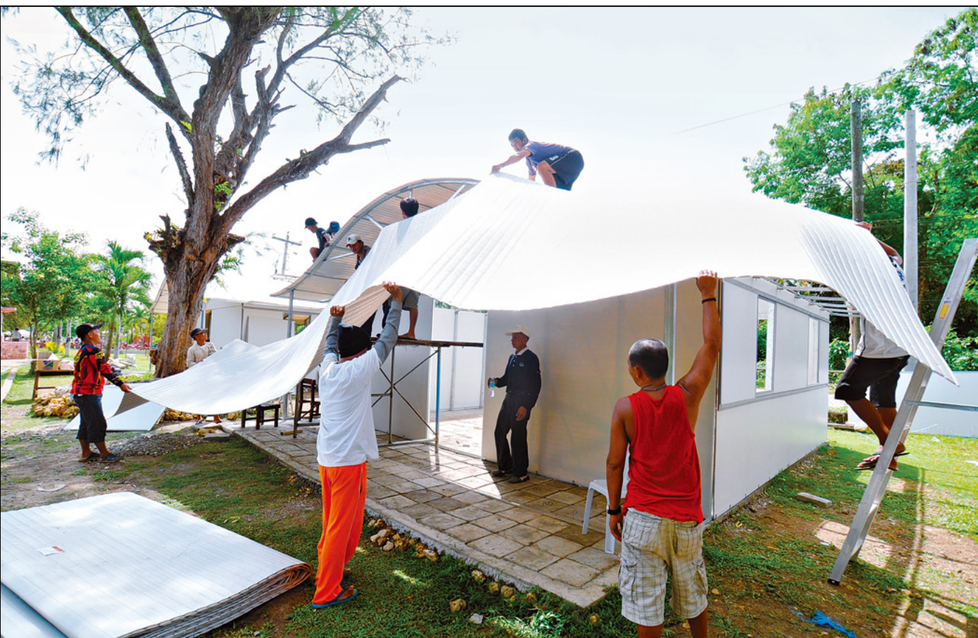
在保和岛科德示中央小学，志工与居民整地铺砖、竖立骨架、装上隔板、覆盖屋顶，简易教室即组装完成。（摄影 / 游锡璋）
