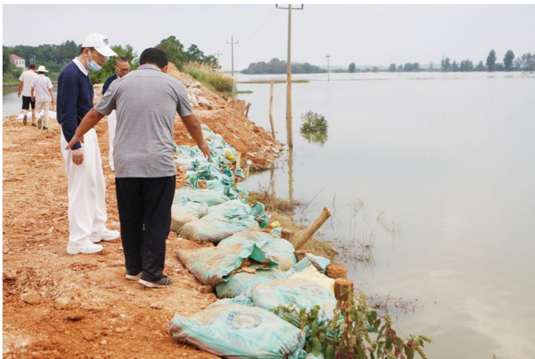
大河镇石超群副书记告诉志工，幸亏有慈济所捐的木桩扎下去，守护着长安湖与花桥河之间的湖堤安全。摄影/郭玲玲
