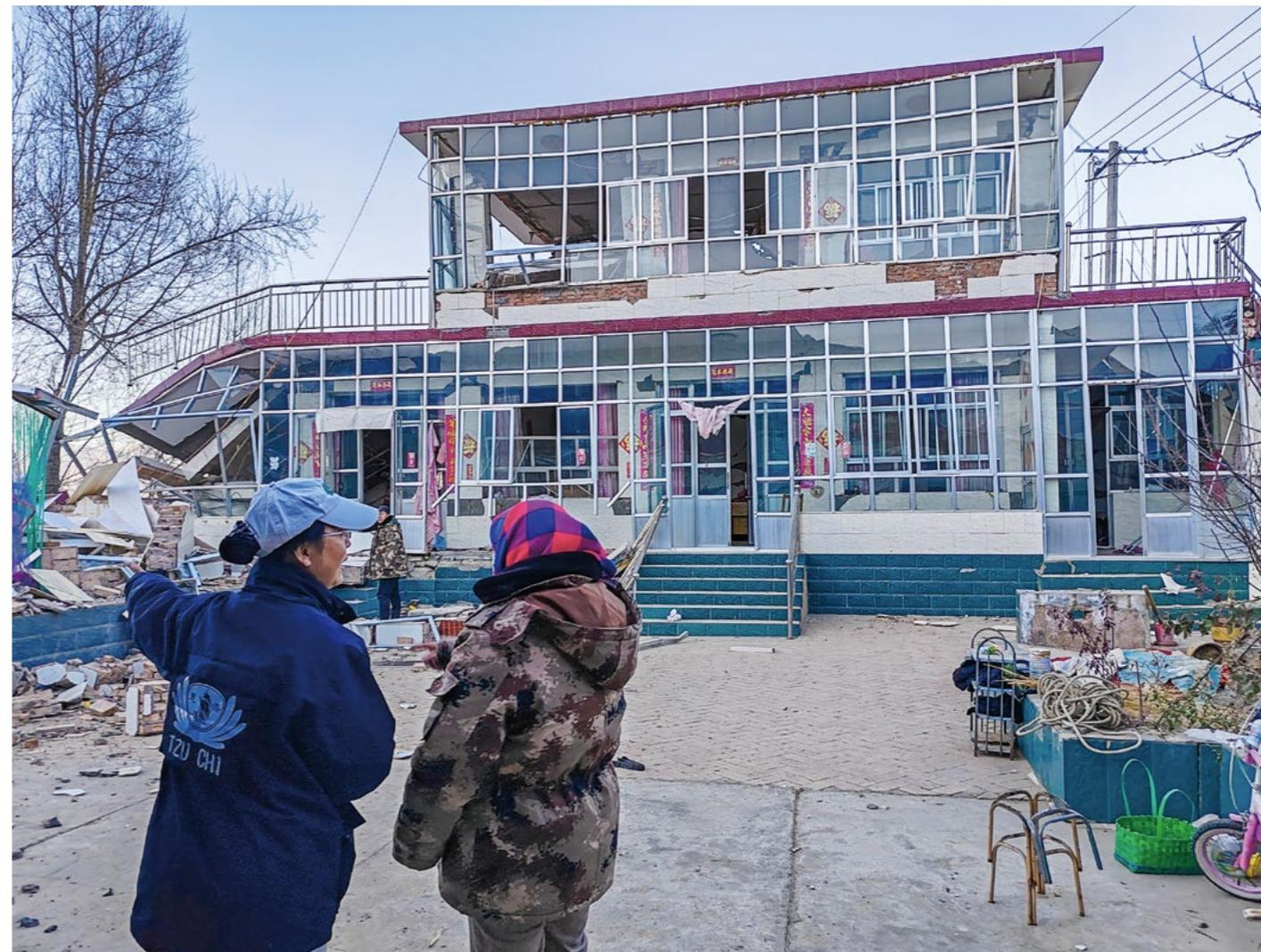
志工在村干部的带领下，来到何大哥家。只见原本二层的楼房因地震，多处墙体出现裂缝或倒塌，已无法住人。摄影/杨瑞霞
