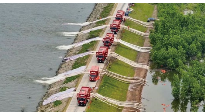
团洲垸决堤口完成合龙，湖南消防救援队伍排涝专业编队到达现场，开始第一批排涝积水作业。照片提供/岳阳日报
