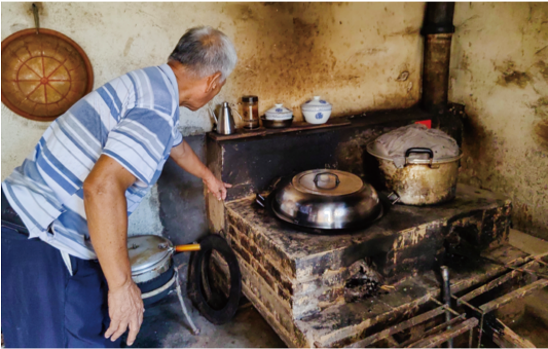
洪水退后，墙上留下80厘米高的清晰水痕。郭阿伯说，清淤用了近6天，累得腰伤复发，灶台上残留的淤泥仍清晰可见。摄影/韩雪娜
