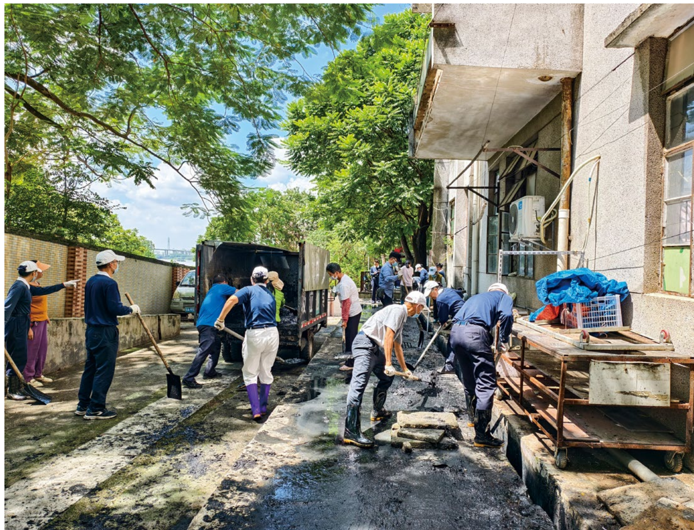
60多位慈济志工和志愿者手持清洁工具，分成多组投入行动。当天的重点工作是清理、疏通排放生活污水的沟渠。摄影/庄严
