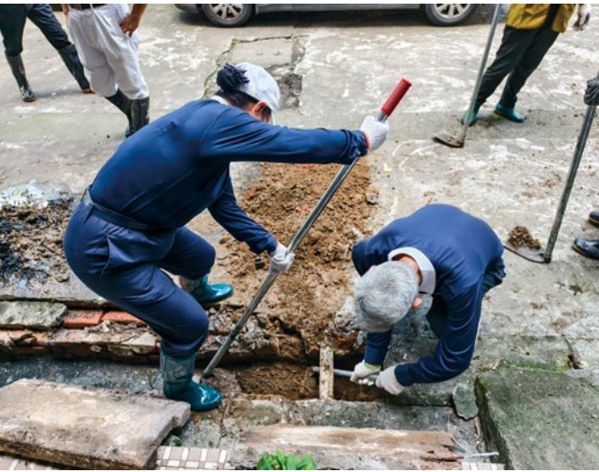
志工两人一组，用钢杆松动泥土，再用锄头挖、铁锹铲，合力撬开水泥板，堵塞的沟渠终于被挖通了。摄影/庄严
