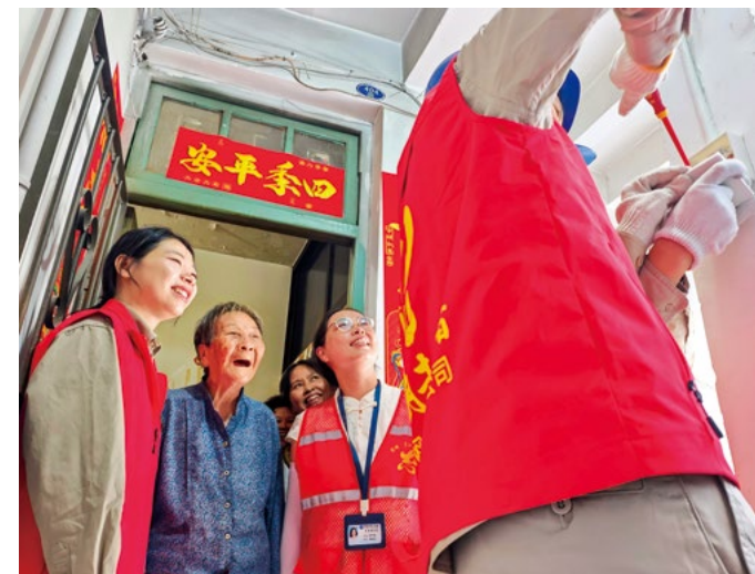
志愿者完成了线路整修，楼道灯亮了。志工扶着李奶奶走到门口：“奶奶，灯亮了，照着你们全家大小出入平安。”摄影/黄德欣
