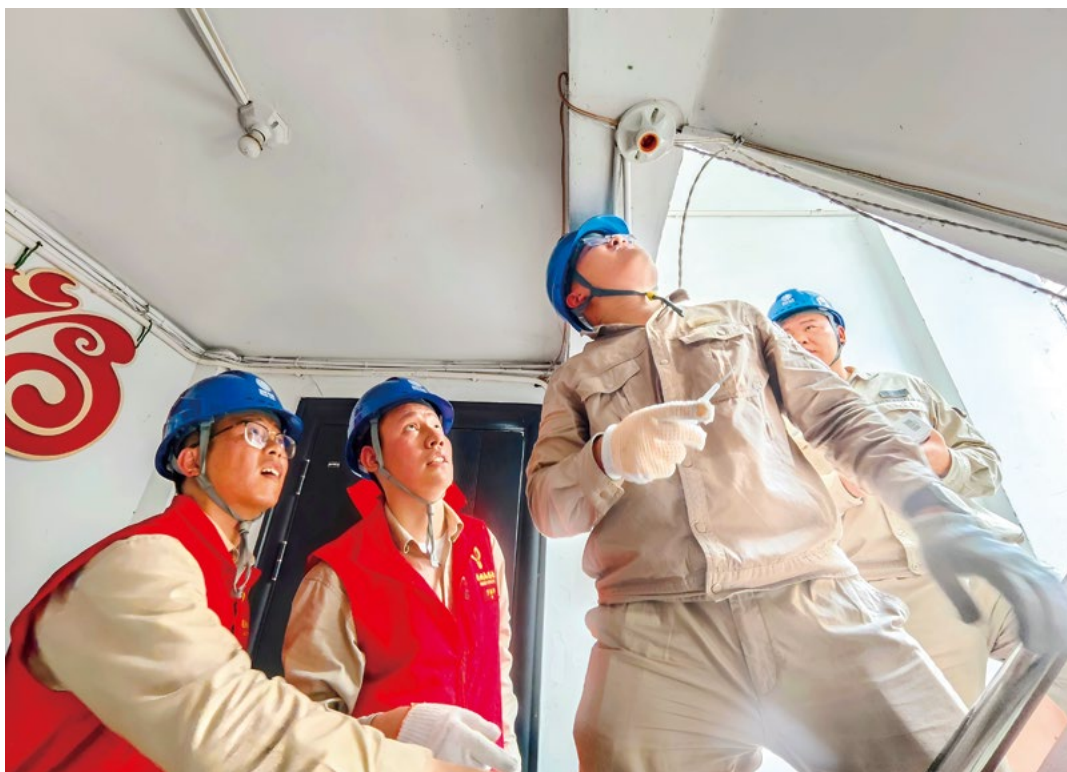
志愿者诊断后，布线、换灯、绝缘包扎、紧固螺丝，一番“手术”下来，一楼和二楼的灯亮了。摄影/黄德欣
