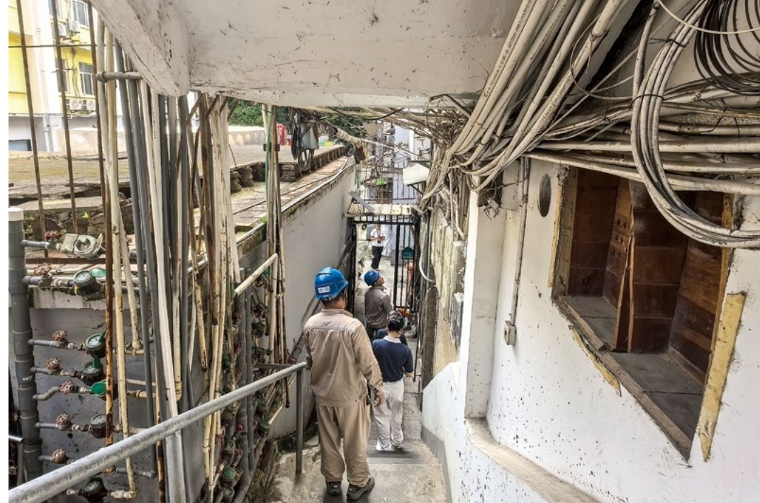
社区网格员、电力志愿者和慈济志工一同走进老旧小区，钻进那些常年昏暗的楼道，挨个“把脉问诊”。摄影/许泳腾
